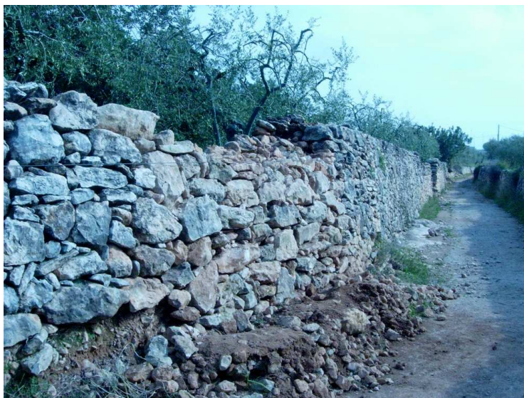
Reconstrucció del marge de pedra seca gairebé acabada
