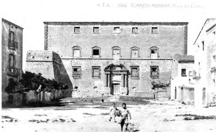
Imatge del Castell de Torredembarra. 1940
